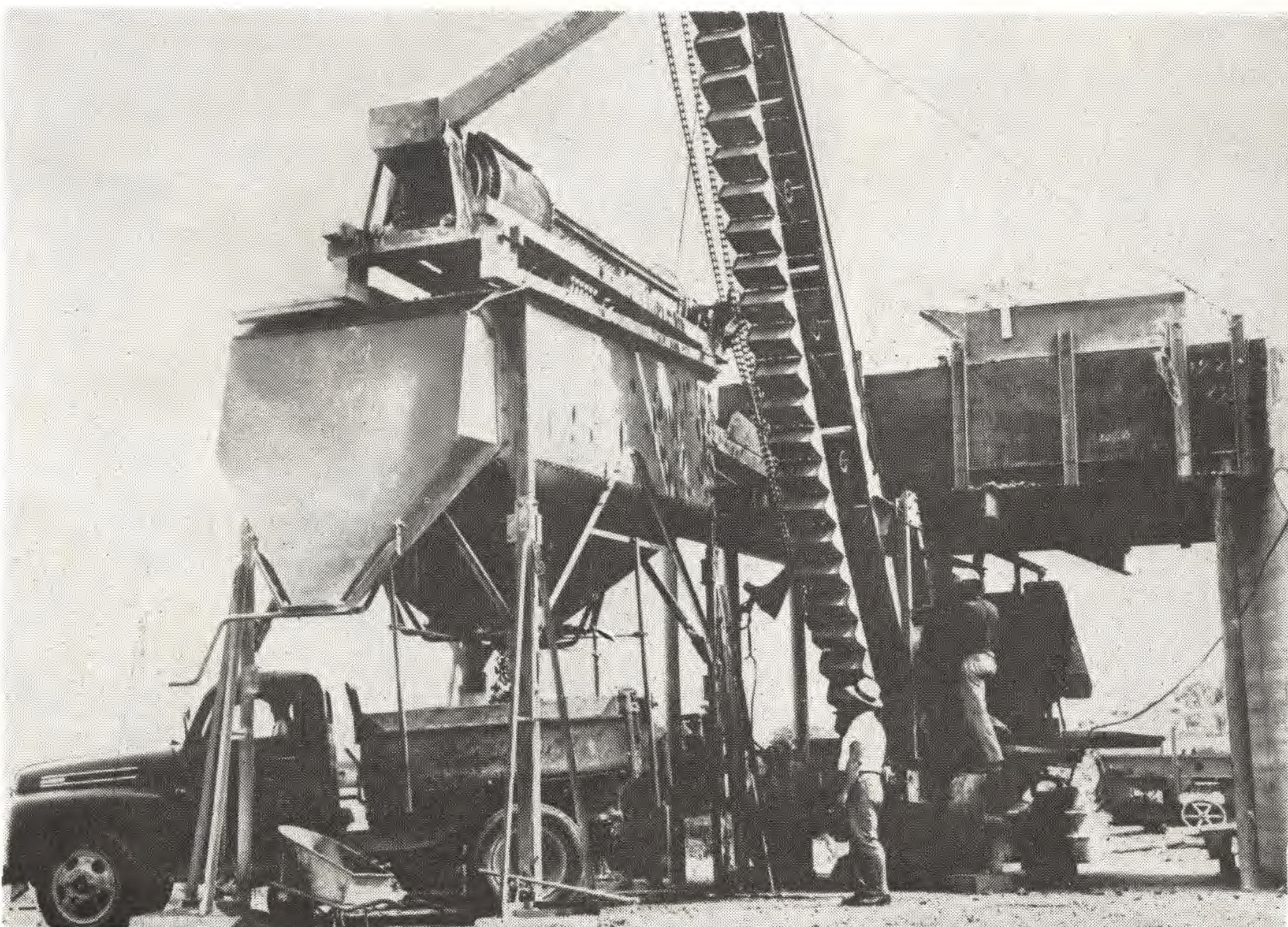
De nieuwe rolbreker, die Steenslag No. 3 tot No. 5 verwerkt.
